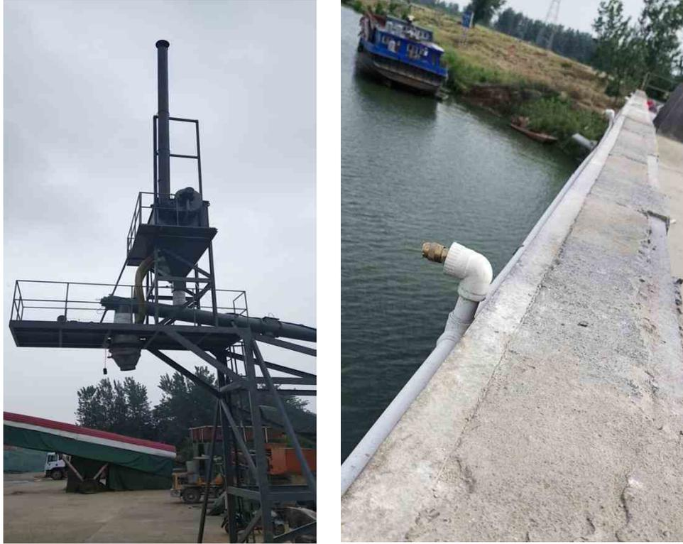
图 3-1 布袋除尘器、固定式喷淋装置
