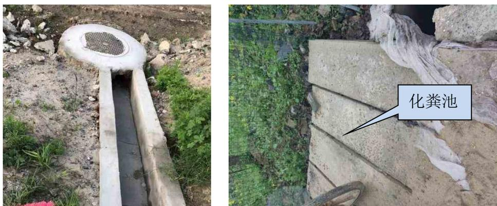
图 3-4 雨水收集口、化粪池图
